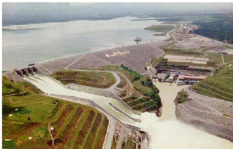
Gambar 2.4 PLTA Mrica Kapasitas 3 x 60,3 MW
