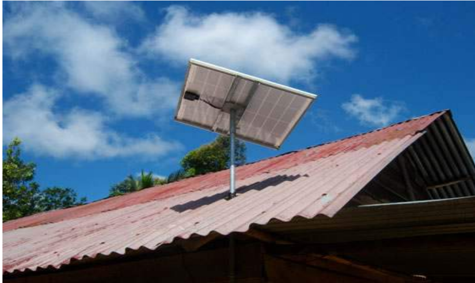
Gambar 2.2 Contoh PLTS SHS ( Solar Home Sistem )
