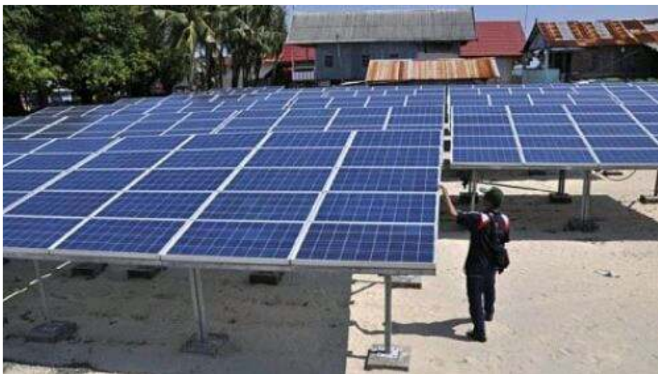
Gambar 2.3 Contoh PLTS Komunal ( On Grid )
