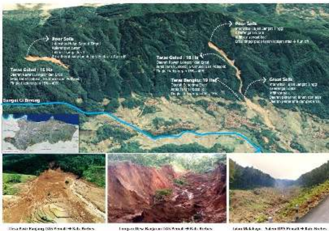
Gambar 6-13 Kondisi Longsor dan Erosi di DAS Pemali
