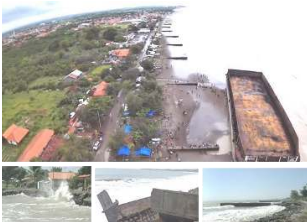
Gambar 5-22 Bangunan Pelindung Pantai Groin dan Jetty
